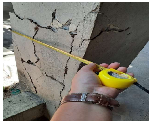
Figura 4: Pilar 2 deteriorado.
